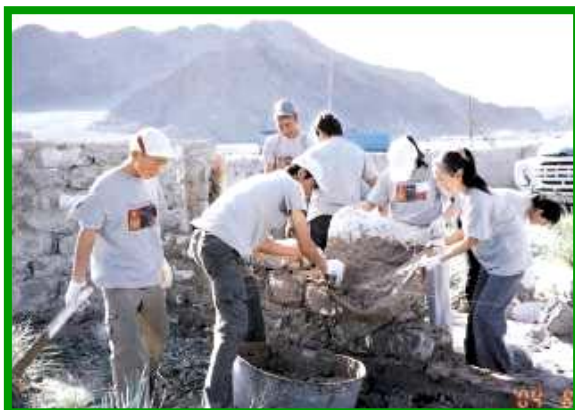
Les bénévoles de RYS reconstruisent un mur en Mongolie en 2004.
